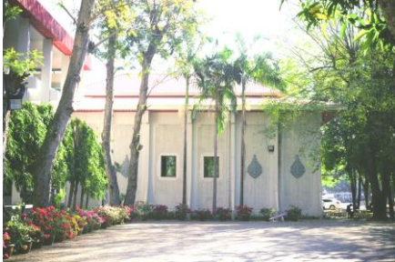
อาคาร 1 (EB1)
