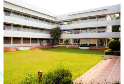
อาคาร 3 (EB3)
