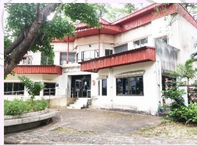
อาคารวันครู (EB5)
