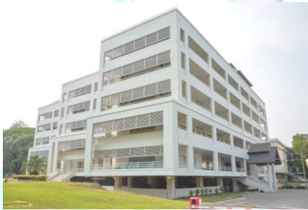
อาคาร 4 (EB4) (อาคารเรียนและปฏิบัติการ 5 ชั้น)
